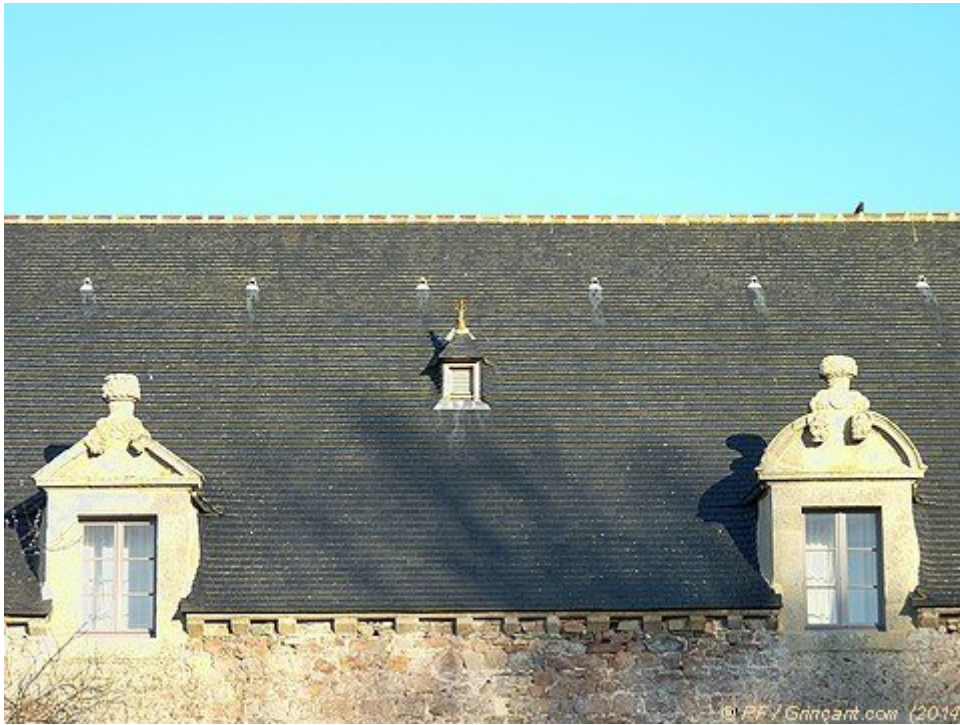
Sur le toit d'une longère de l'abbaye, trois fenêtres, dont une de poupée
