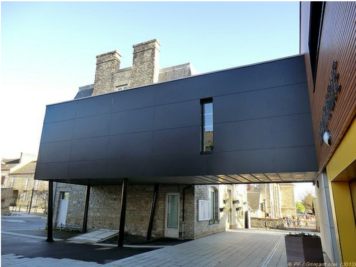
Passerelle couverte reliant les deux bâtiments. À droite, entrée principale de la médiathèque.
